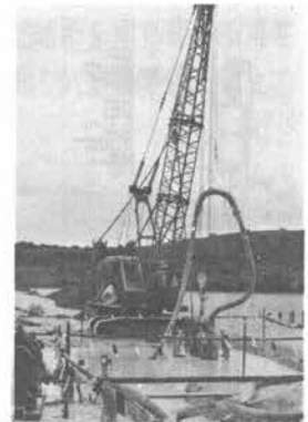
写真-2 テスト現場
