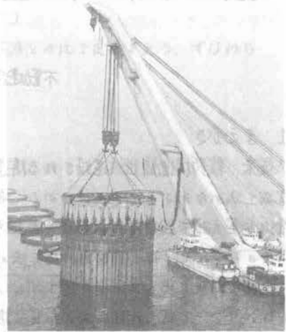
(写真-1) クレーン船による施工状況
