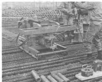
写真 TS工法用圧着装置
