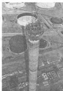
写真-1 施工全景
