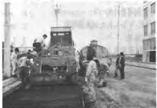
写真-2 舗装作業
