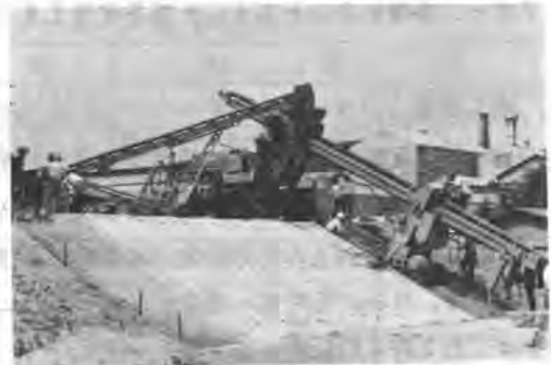
写真-1 法面コンクリート打設機と作業風景
