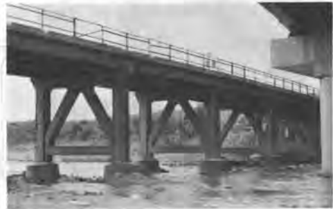
写真-1 旧荒井橋全景（右端新橋）
