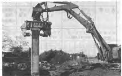
写真-3 コンデストラ橋脚取りこわし状況
