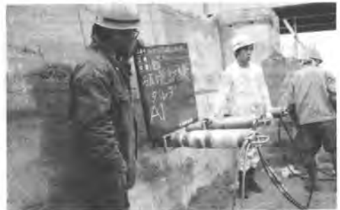
写真-4 ダルダによる橋台取りこわし状況
