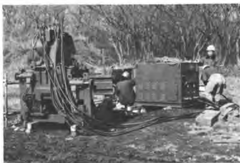
写真-1 掘削機本体と油圧ユニット
