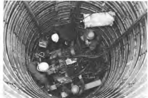
写真-3 掘進作業
