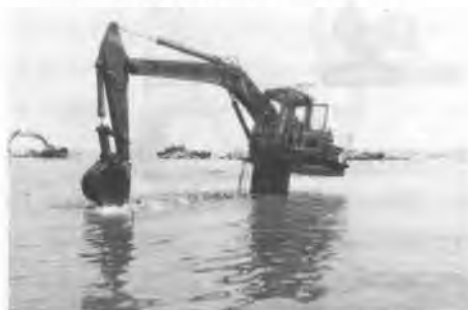
水中掘削中のシャローショベル
