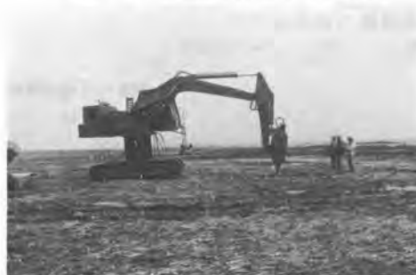
ブレーカーによる砕岩(干出時)
