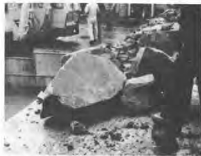
写真-3. リッパバケットで掘削した軟岩
