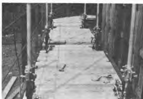
写真/ リフティングユニット取付状況
