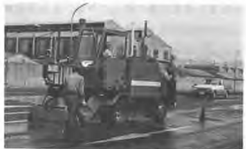
写真—1 粗面の成形作業
