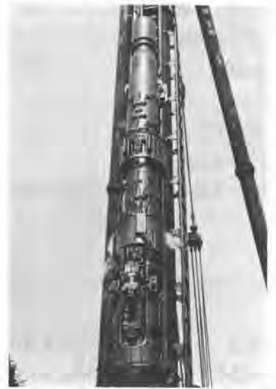
写真-1. 稼働中のKC25ディーゼルパイルハンマ
