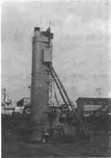
写真-1 防音カバー付杭打機
