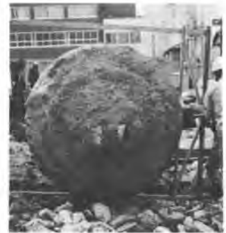
写真-3 拡底部寸法検測
