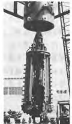
写真-1 シャフト部掘削時
