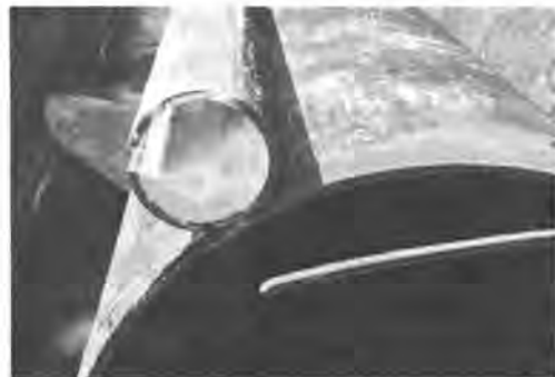
写真-2 継手の切断面
