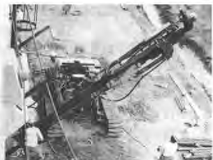
ポンプ場建設工事に稼働するMCD7
