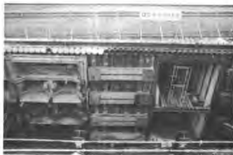
写真-2 OSA機による掘削完了状況
