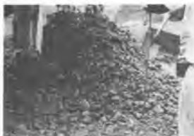
写真-5 ダンピングした硬練りコンクリート
