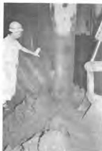
写真-2 埋戻し部の掘削状況
