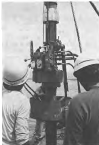
写真-1 本体側操作盤
