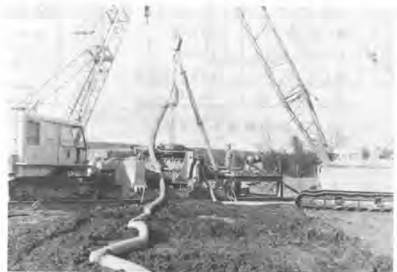
写真-1 リバースの施工（中央がベノーク）
