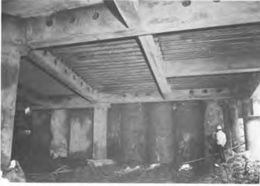
写真-1 完成した柱列杭式土留壁
