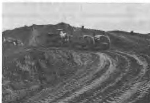
写真-4 緑ヶ丘団地運搬路の状況
