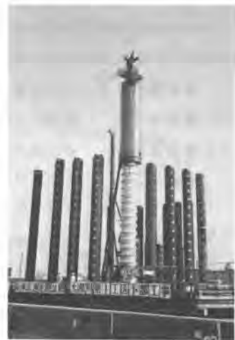
写真-1 施工状況
