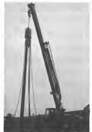
写真-1 鋼矢板打込み試験
