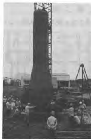
写真-4 掘り起こし杭
