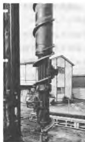
写真-1 拡大刃 外径 75 cm (拡大時)
