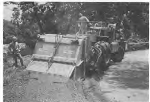
写真-3 施工状況(破砕)
