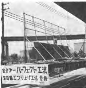
防護工地組状況
