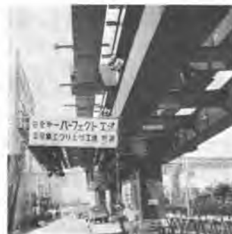
防護工吊り上げ状況
