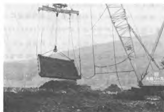
写真-3 ずりの放出作業
