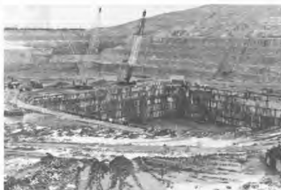
写真-1 二次掘削工事の状況
