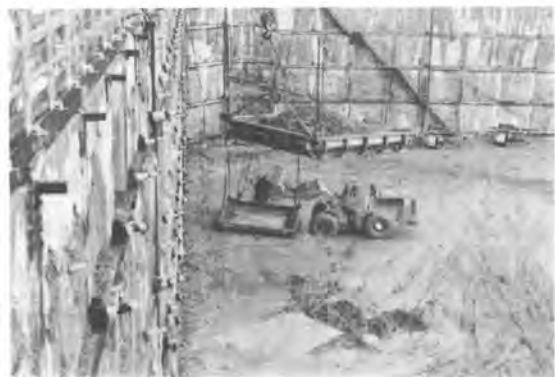
写真-2 ずりの積込み及び揚土作業
