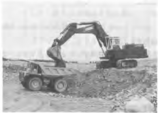
写真3 ダム現場でのUH50バックホウショベル。
