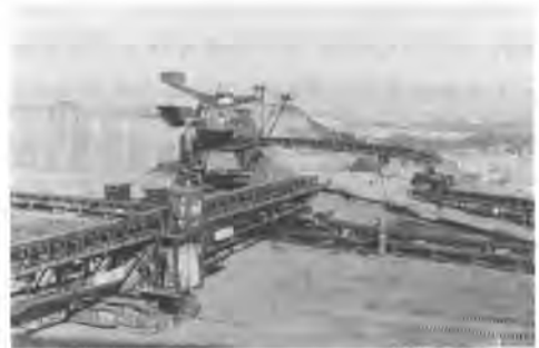
写真-1 京急釜利谷土取工事とB.W.E.
