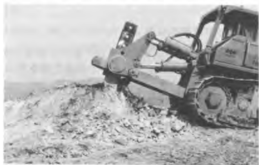
写真-2 同所破碎後のリッピング
