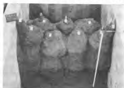
写真-4 ダブルバッカー工法
