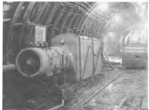
写真-1 設置状況 (右側: 切羽, NATM工事中)
