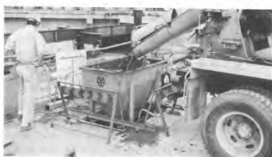
写-3 架橋上に設置
