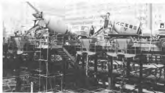
写-2 ハネ出し架台に設置
