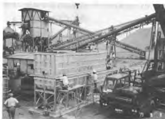
写真-2 組立て状況
