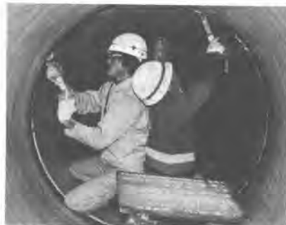
継手部のシーキング処理
