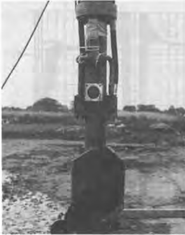
図-2 高圧水噴射ノズル
