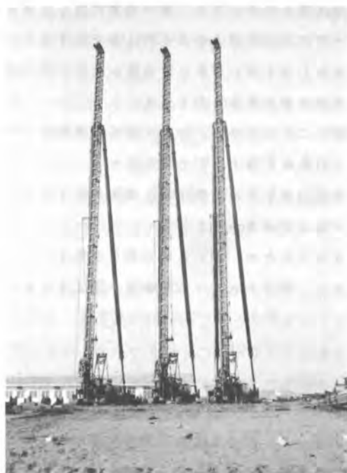
写真-1 打設機全景
