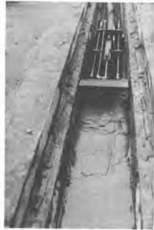
写真-1 清掃状況
