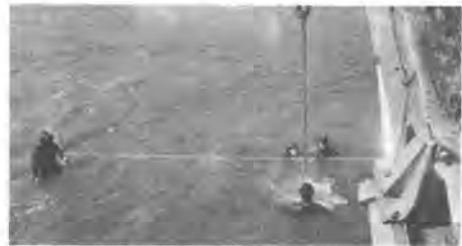
写真-2 増殖ブロック据付
