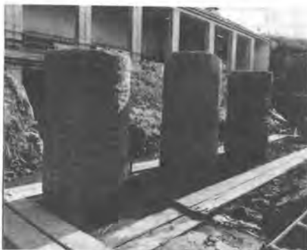
写真-4 掘り出した固結パイル
