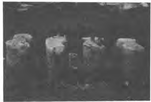
写真-1 造成パイルの出来上り形状
