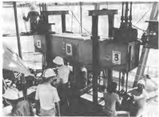
写真-4 リフトアップ装置
