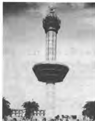
写真-2 リフトアップ中
