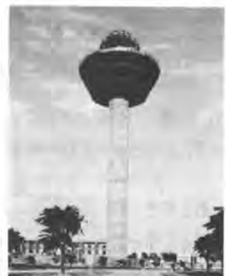
写真-3 リフトアップ後
