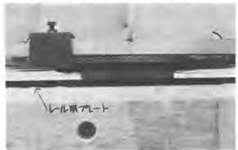
写真1 スライド支承部
