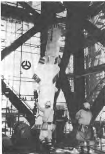
写真-4 柱吊込み
