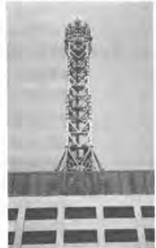
写真-1 屋上鉄塔(実施例)
