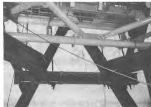
写真-5 鉄塔受け架台
