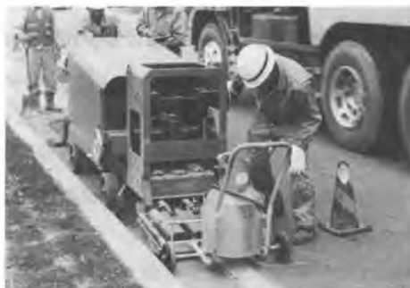
写真-3 加熱方式による切削状況
