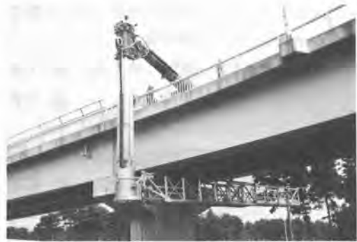
写真-3 作業状態
