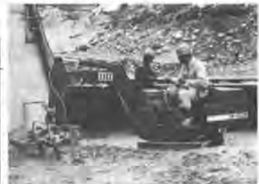
写真-1 機械施工の場合
