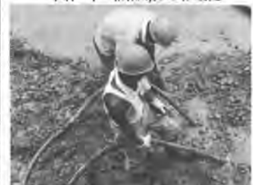
写真-2 人力施工の場合
