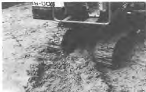
写真-3 走行状況
